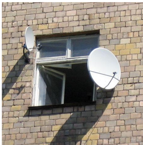
Антенны приема сигнала со спутника Eutelsat W4 (36° в.д.) и Sirius 2/3 (5° в.д.)
