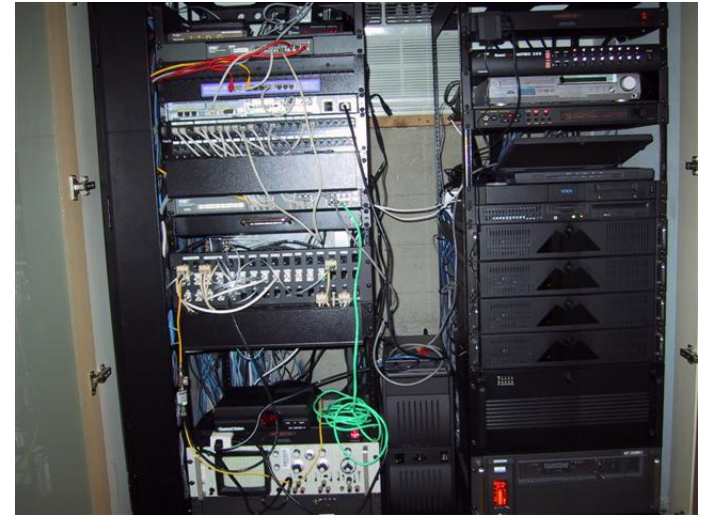
Рис. 15 Реализация ПАК на примере автоматизации СКВ «серверного» помещения
