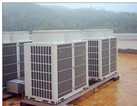
Наружный блок мультизональной системы серии R, с двумя компрессорами, работающий на фреоне R22 в режиме холод/тепло с номинальной мощностью 30.000Вт
